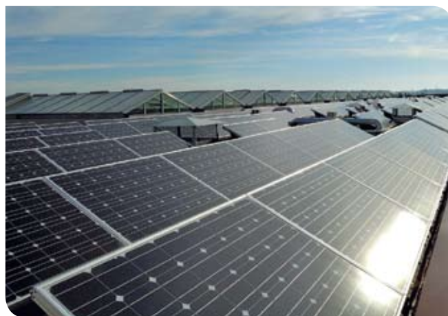
Conception et fourniture de la solution photovoltaïque du Lycée Kyoto de Poitiers en France
