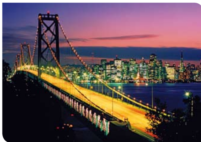
Rénovation du San Francisco Bay Bridge en Californie aux États-Unis
